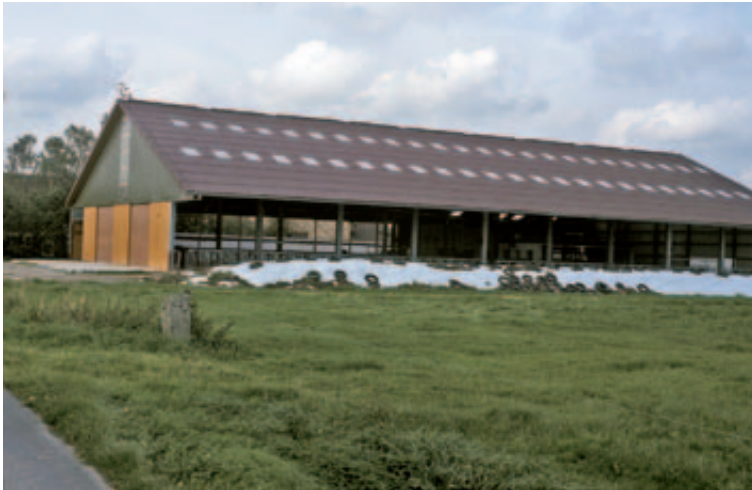
Abb. 9: Moderner Kuhstall in Hallenbauweise (Boxenlaufstall). Stallneubauten dieser Kategorie sind zugig und bieten keine geeigneten Möglichkeiten zur Nestbefestigung. Sie stellen damit keinen gleichwertigen Ersatz für die früheren Kuhställe dar. – Modern type of large and open free-stall barn for cows. Buildings of this category are very draughty and less sheltered than the former tie-stall barns. They are no equivalent compensation for lost Barn Swallow breeding sites.
